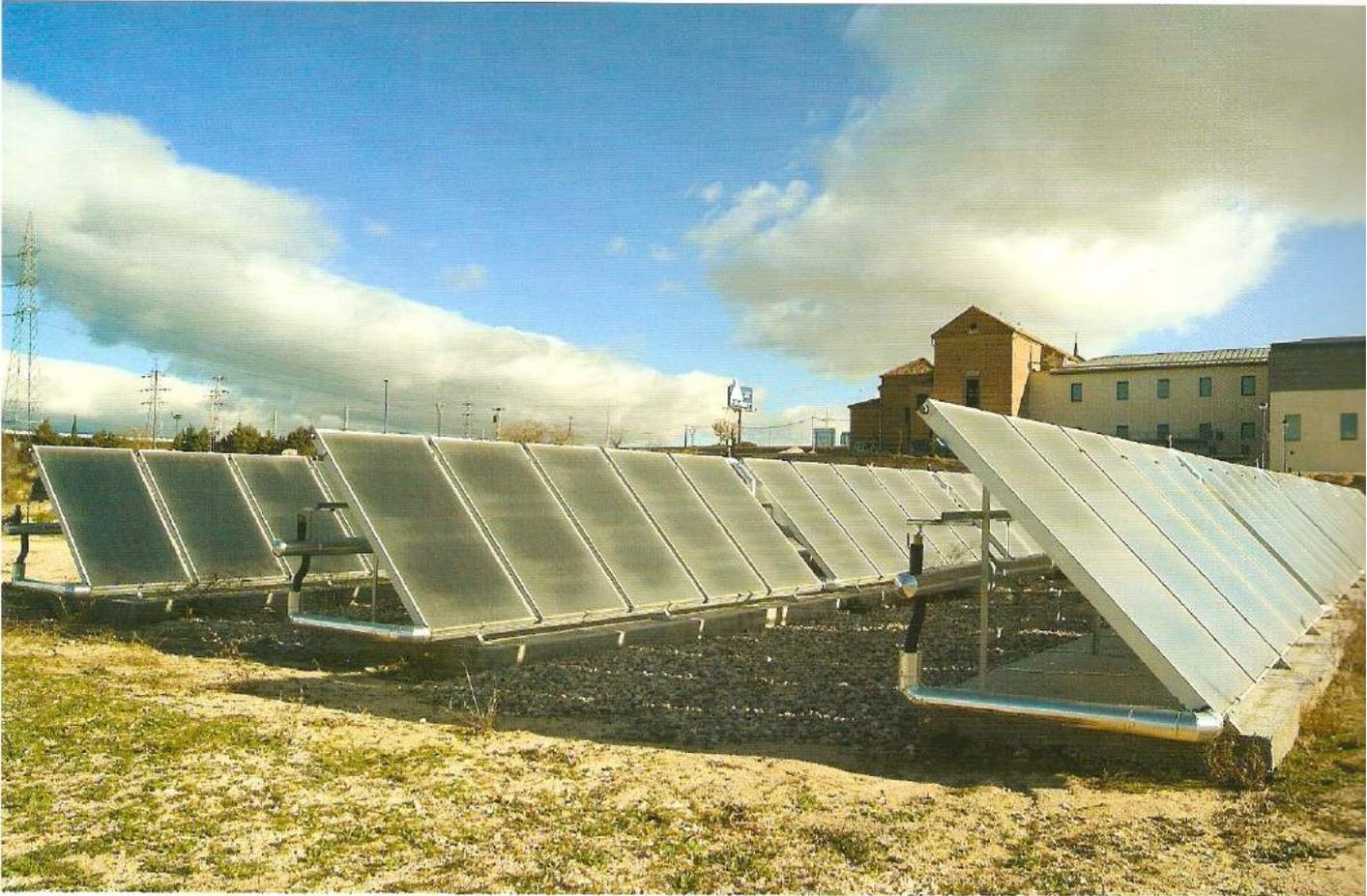
*Paneles solares térmicos para producir agua caliente sanitaria y apoyo del suelo radiante que se ha instalado en el Monasterio.*
